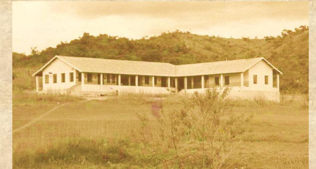
Prédio da Escola Dom Silvério.
