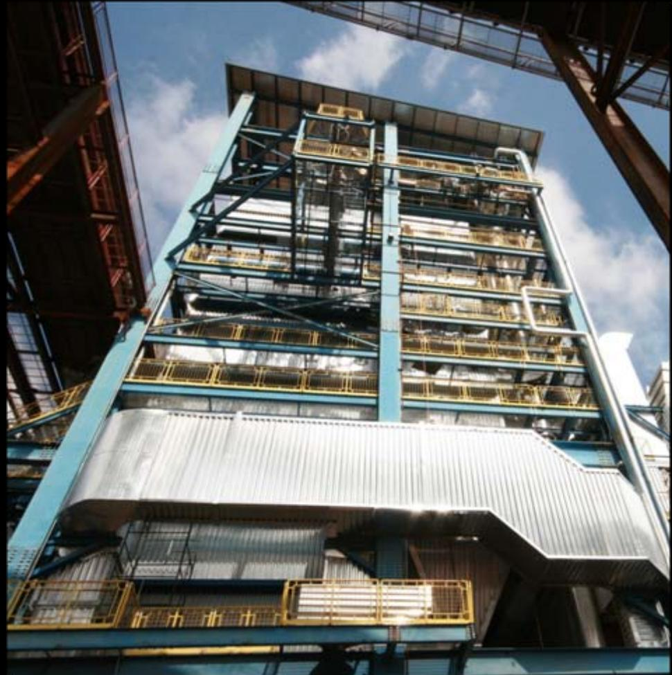
**DEDINI MULTIFUEL BOILER – BAGASSE, STRAW AND BIOGAS UTILIZATION AS FUELS
