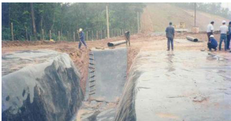
Figura 27 – Remoção de substâncias químicas no Jardim Keralux, São Paulo, 1997
