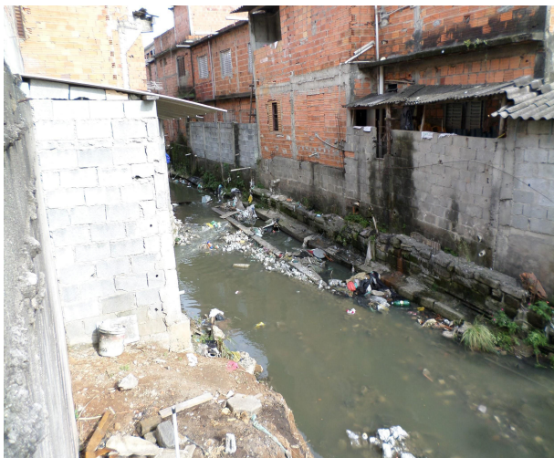
Figura 3 – Esgoto a céu aberto em Carapicuíba semelhante ao Riacho Doce
