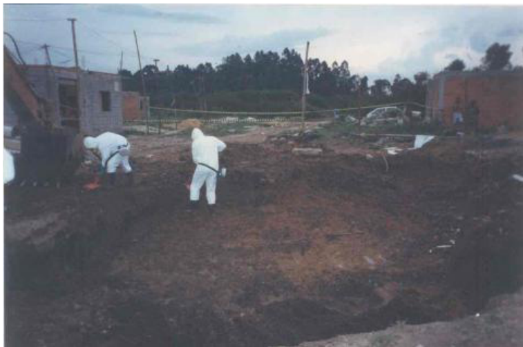
Figura 26 – Remoção de substâncias químicas no Jardim Keralux, São Paulo, 1997
